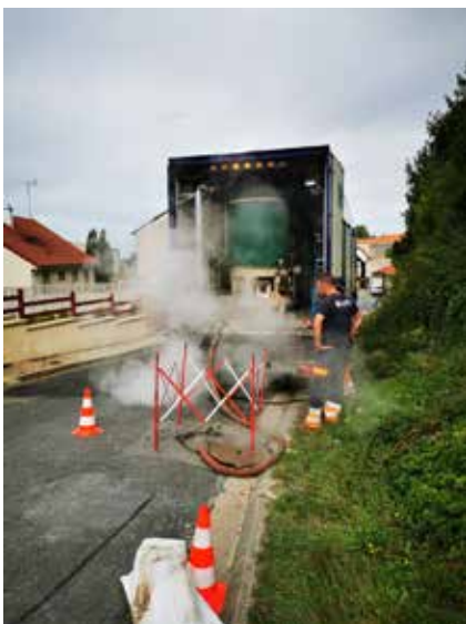
Réhabilitation des canalisations
