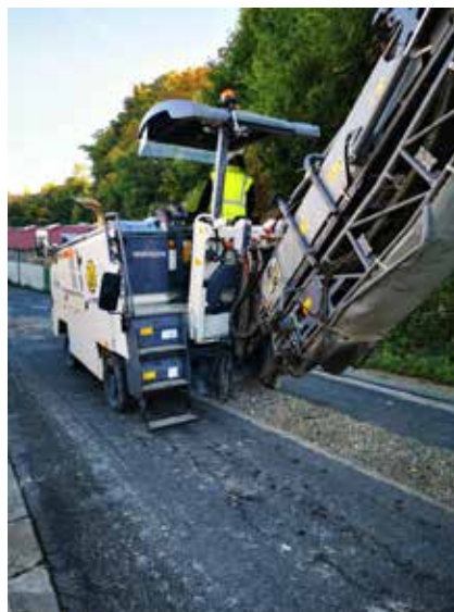
Revêtements de la chaussée
