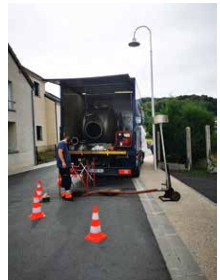
Entretien du réseau d'eau pluvial
