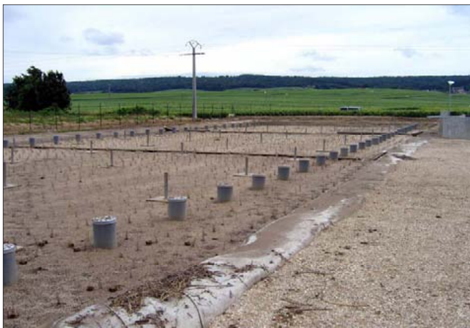
Vue de l'étage N°1
